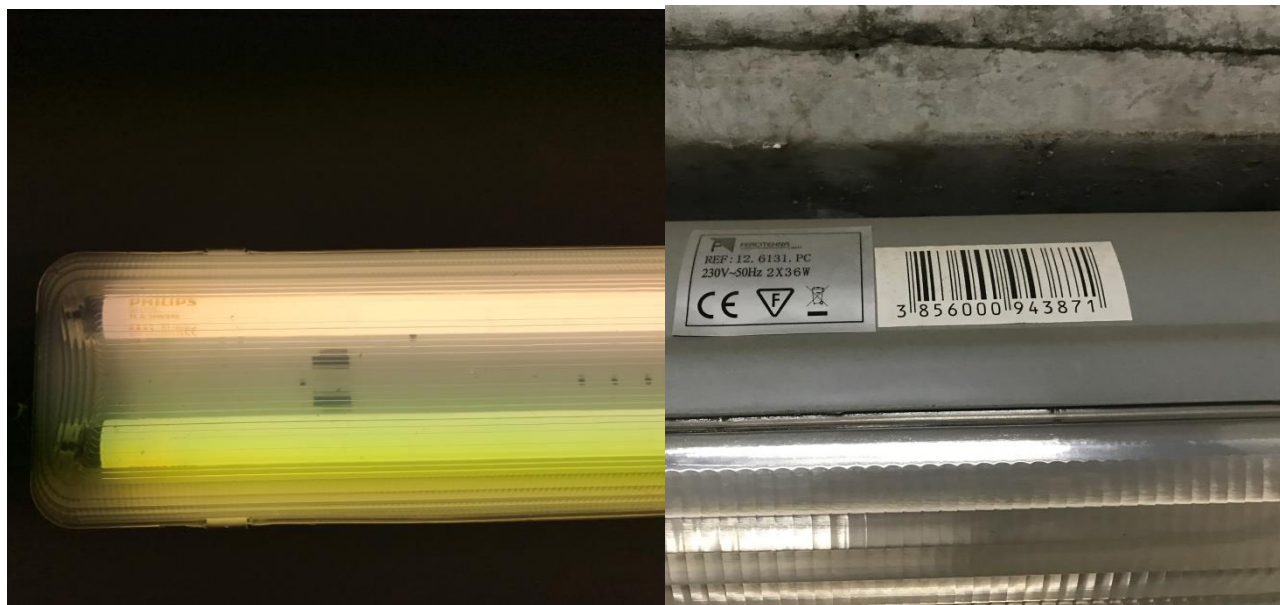
Slika 3.4. Natpisna pločica postojećeg rasvjetnog tijela – FEROTEHNA/PHILIPS 2x36 W
